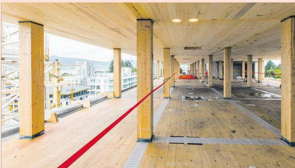
01 Residencia de estudiantes en Vancouver Imagen de la construcción del Brock Commons Tallwood House, un edificio de madera de 54 metros y 18 pisos.
